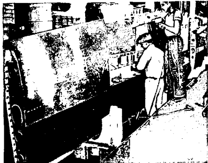
Фиг. 20. Консоли крыла перемещаются по проходу между рабочими платформами. В конце этой ветви линии консоль окрашивается в окрасочной камере, после чего поступает на вторую ветвь этой же линии
