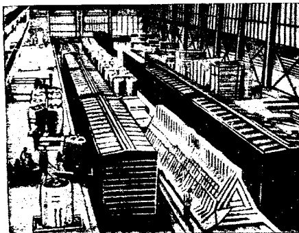
Фиг. 104. Моторные установки, винты и материалы на заводе Консолидейтед-Валти в Форт Уорте подаются в вагонах непосредственно в склады, расположенные вблизи соответствующих участков сборки или цехов для их обработки
