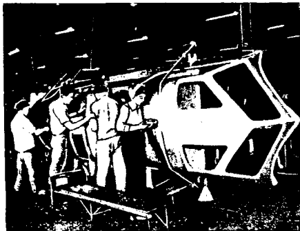
Фиг. 59. Сборка надстройки фюзеляжа
