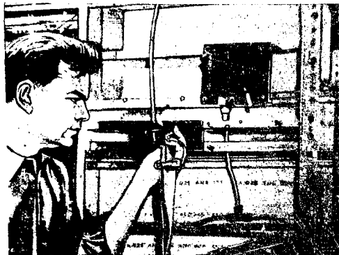
Фиг. 121. Установка узлов крепления ремней для укрепления грузов
