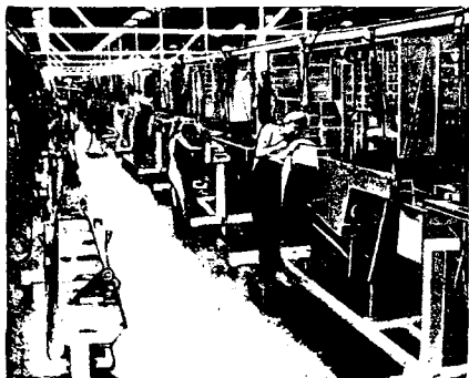
Фиг. 19. Задние секции крыла—правые на одной линии и левые на другой—движутся к стендам, где они будут соединены с передней секцией. Эта линия непрерывно движется
