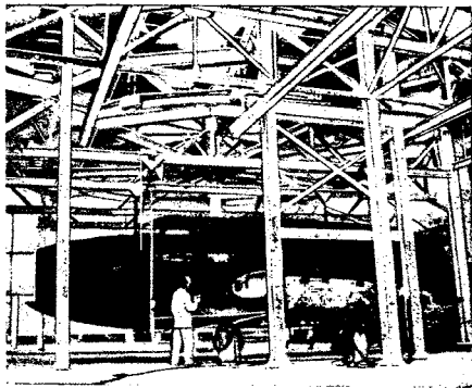
Фиг. 73. Громдный поворотный круг в окрасочной камере позволяет производить окраску под прямым углом к воздушным потокам, циркулирующим в камере. Водные завесы справа и слева в соединении с воздушными завесами поддерживают в камере чистую атмосферу, не содержащую паров покрытия
