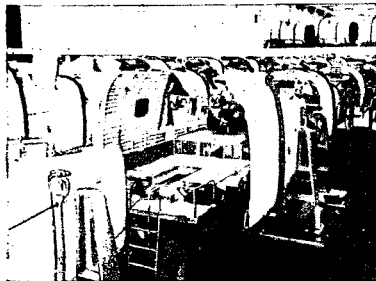
Фиг. 152. В этом приспособлении собирается из трех частей — пола кабины летчика и двух боковых панелей — носовая часть фюзеляжа
