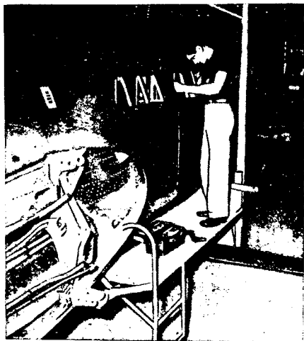
Фиг. 74. Рабочие платформы, временно прикрепленные к кронштейнам крыла, передвигаются над полом и обеспечивают легкий доступ к нужным местам
